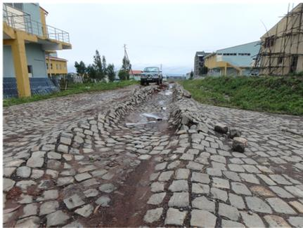
図4 膨潤性粘土地盤上の道路
